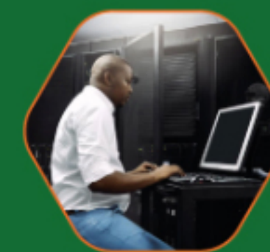
INFOGERANCE ET CONTRATS DE MAINTENANCE DÉDIÉS
